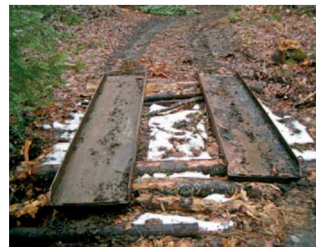
Crédit photo : Aménagement des Sommets
